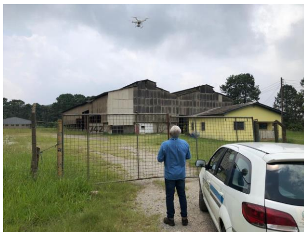
Figura 59 - Realização de sobrevoo com drone para verificação da situação do Brownfield.
