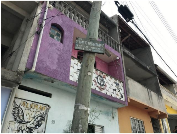
Figura II 1 - Rua Dr. Emilio Hernandez Aguilar, snº, Franco da Rocha, em 28/09/17, empreendimento não apto.
