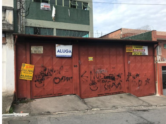
Figura II 41 - Rua Tomé Andrade, n° 95, em São Paulo, em 19/01/18, empreendimento não apto.
