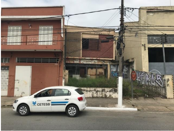
Figura II 53 - Av. Tereza Cristina, nº 248, em São Paulo, em 19/01/18, empreendimento não apto.
