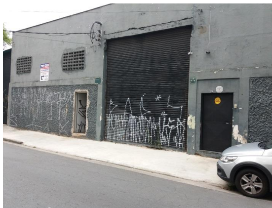
Figura II 26 - Rua Distrito Industrial, nº 175, em Santo André, em 18/12/17, empreendimento não apto.
