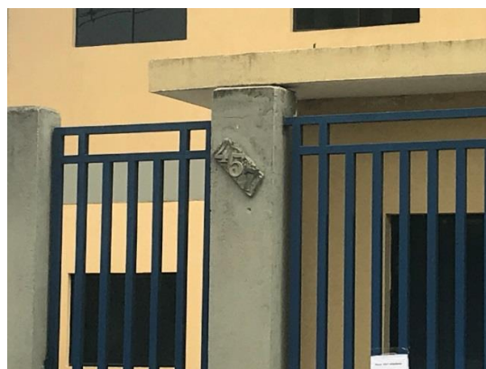
Figura II 63 - Rua Ernesto Joaquim Souza, nº 457, em Suzano, em 16/02/18, empreendimento não apto.
