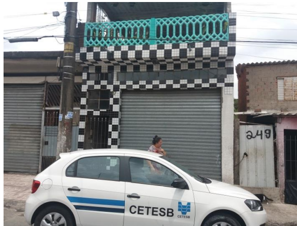
Figura II 33 - Rua Édson Erasmo da Silva, nº 245, em Mauá, em 21/12/17, empreendimento não apto.
