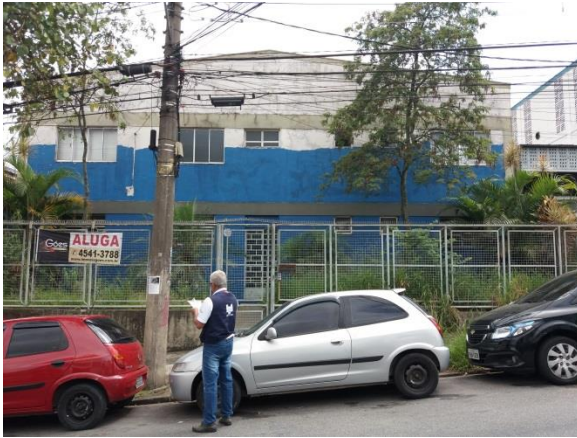
Figura II 31 - Rua Vitoria Pena Giorgi, nº 65, em Santo André, em 18/12/17, empreendimento não apto.
