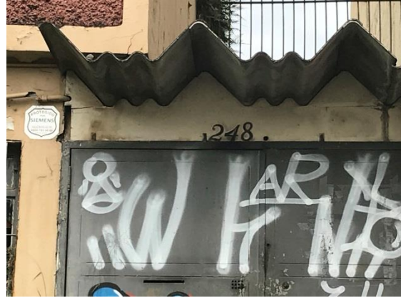
Figura II 54 - Av. Tereza Cristina, nº 248, em São Paulo, em 19/01/18, empreendimento não apto.
