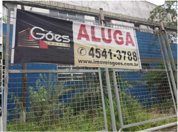
Figura II 32 - Rua Vitoria Pena Giorgi, nº 65, em Santo André, em 18/12/17, empreendimento não apto.
