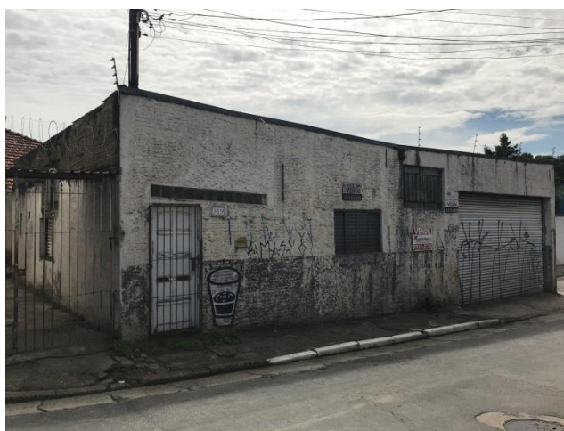
Figura II 48 - Rua do Lago, n° 319, em São Paulo, em 19/01/18, empreendimento não apto.
