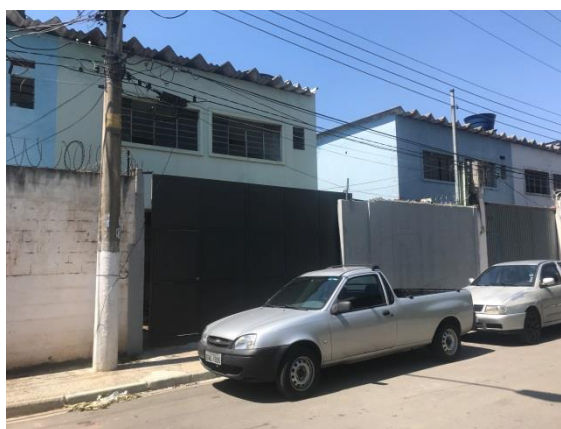
Figura II 25 - Rua Silvio Romero, nº 165, em Diadema, em 16/11/17, empreendimento não apto.
