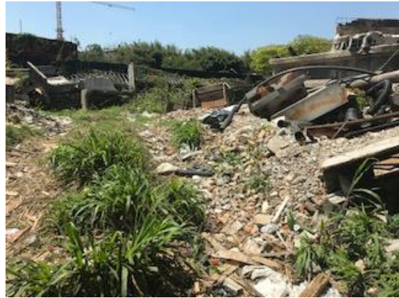
Figura II 5 - Av . Eliseu de Almeida, 3501, São Paulo, em 05/10/17, empreendimento não apto.
