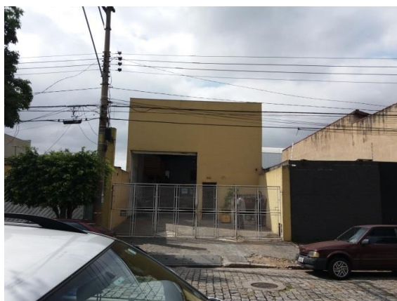
Figura II 27 - Rua Barbara Heliodora, nº 222, em Santo André, em 18/12/17, empreendimento não apto.
