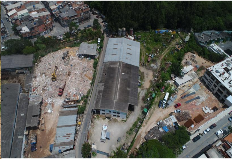
Figura 36 – Realização de sobrevoo com drone para verificação da situação do empreendimento.
