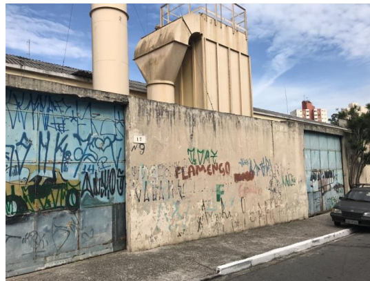
Figura II 45 - Rua Maria Teresa Gaudino, nº 17, em São Paulo, em 19/01/18, empreendimento não apto.
