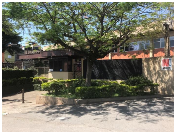
Figura II 22 - Av. Fundibem, nº 625, em Diadema, em 16/11/17, empreendimento não apto.
