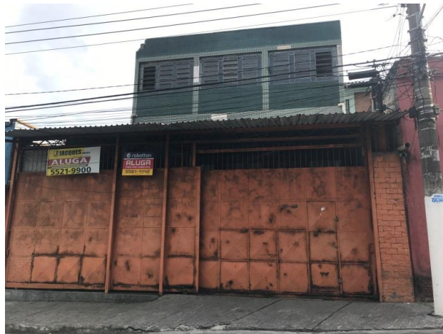
Figura II 42 - Rua Tomé Andrade, n° 235, em São Paulo, em 19/01/18, empreendimento não apto.
