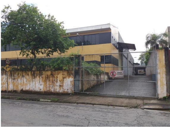
Figura II 16 - Estrada Particular Yae Massumoto, 193, em São Bernardo do Campo, em 26/10/17, empreendimento não apto.
