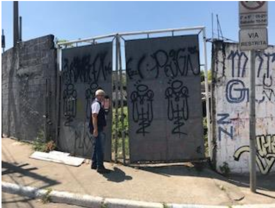
Figura II 4 - Av . Eliseu de Almeida, 3501, São Paulo, em 05/10/17, empreendimento não apto.
