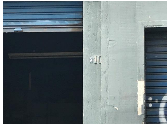
Figura II 50 - Rua do Lago, nº 310, em São Paulo, em 19/01/18, empreendimento não apto.
