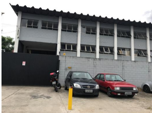
Figura II 39 - Av. Novo Brasil, 111, em Guarulhos, em 19/01/18, empreendimento não apto.
