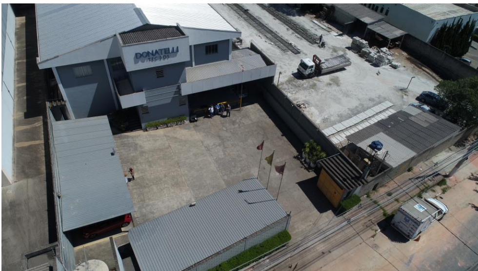
Figura 28 - Imagem aérea das condições locais utilizando Aeronave Remotamente Pilotada.
