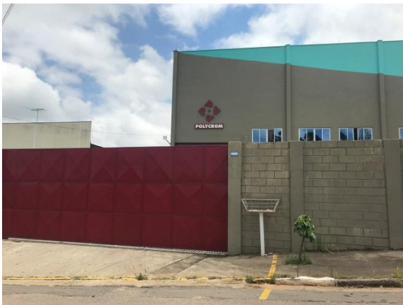
Figura II 55 - Av. Londres, nº 155, em Arujá, em 16/02/18, empreendimento não apto.
