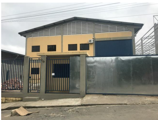
Figura II 62 - Rua Ernesto Joaquim Souza, nº 457, em Suzano, em 16/02/18, empreendimento não apto.
