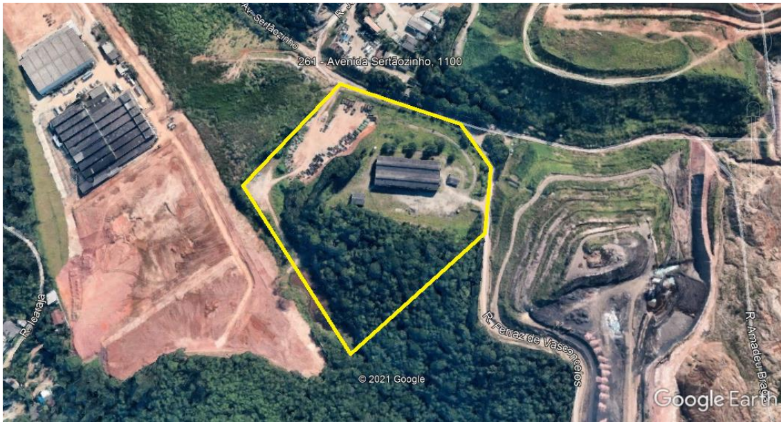
Figura 52 – Visualização da situação do Brownfield no contexto do aterro sanitário.
