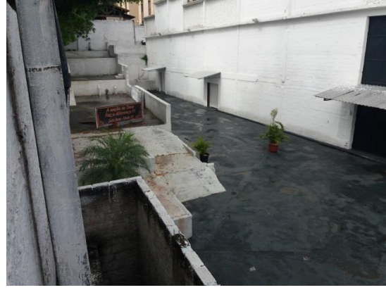
Figura II 14 - Rua Senador Manoel Cordeiro Vilassa, 945, em São Bernardo do Campo, em 26/10/17, empreendimento não apto.
