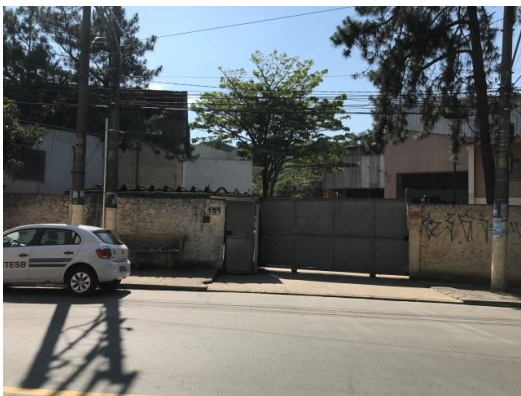
Figura II 18 - Rua Rio de Janeiro 151, em Diadema, em 16/11/17, empreendimento não apto.
