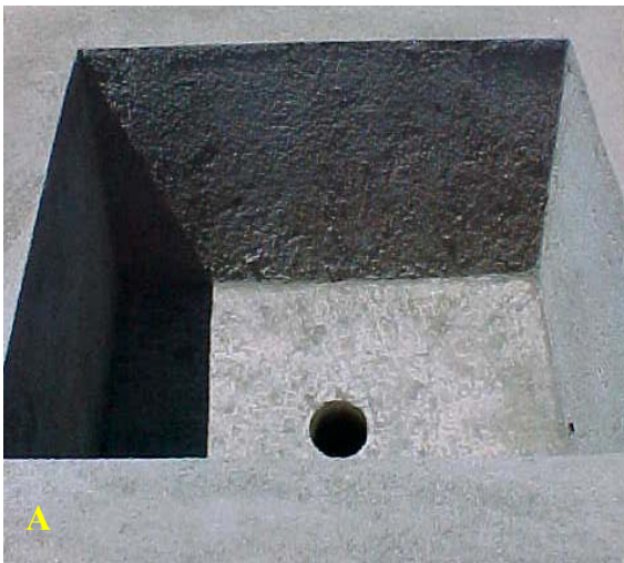
Figura 6. Vista do tubo de entrada no fundo da caixa de carga (A) e a 0,30 m do fundo do biodigestor (B).
