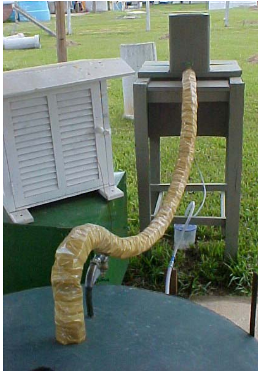
Figura 9. Vista da tubulação condutora do fluido de aquecimento do substrato, com detalhe do reservatório sob o qual se processou a queima de parte do biogás.
