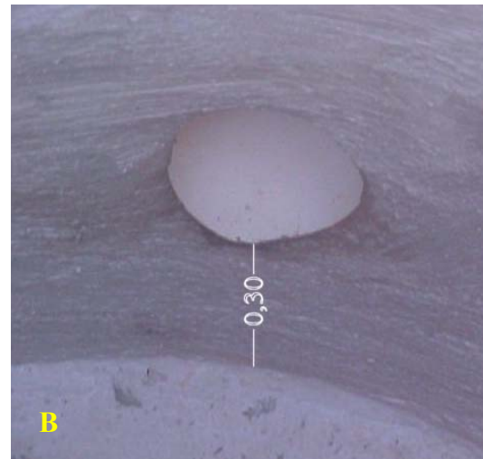
Figura 6. Vista do tubo de entrada no fundo da caixa de carga (A) e a 0,30 m do fundo do biodigestor (B).
