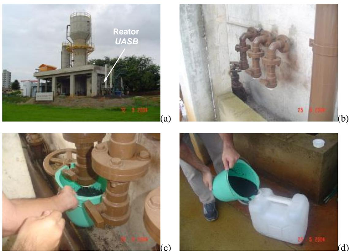
Figura 4.4. (a) Reator *UASB* da ETE USP-São Carlos. (b) Válvulas de descarga de lodo. (c) Coleta do lodo. (d) Armazenamento do lodo em recipiente.
