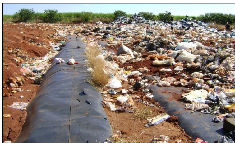
Figura 79 – Disposição irregular de resíduos sobre vala esgotada – 2015
