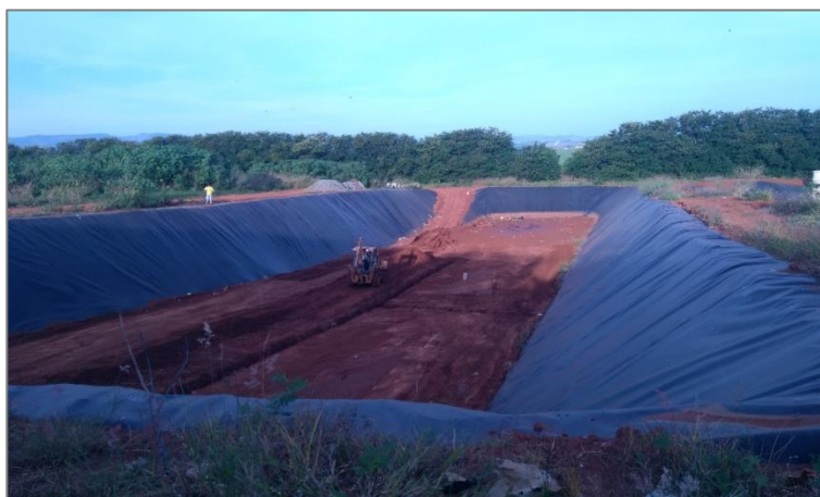
Figura 96 – Construção de novas valas – 2019
