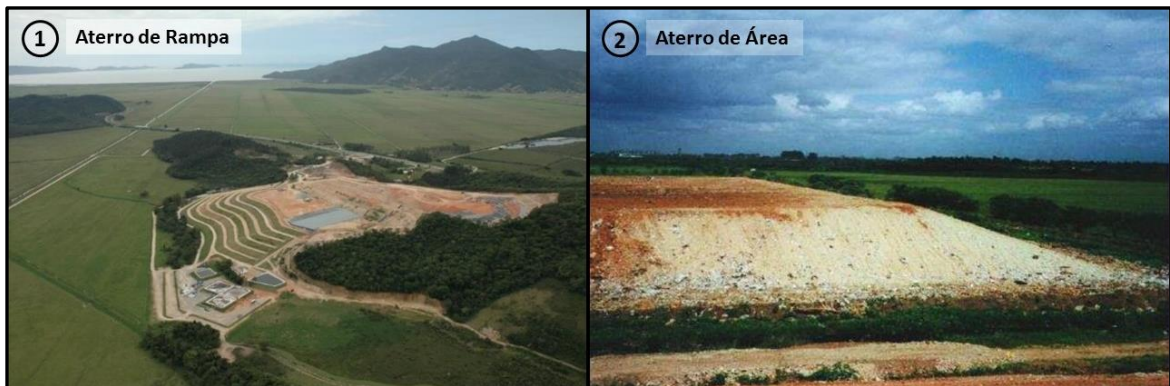
Figura 2 – Tipos construtivos de aterros acima do nível original do terreno
