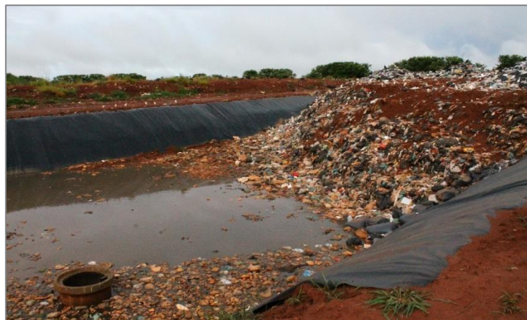
Figura 88 – Vala irregular (sistema de drenagem comprometida) – 2017
