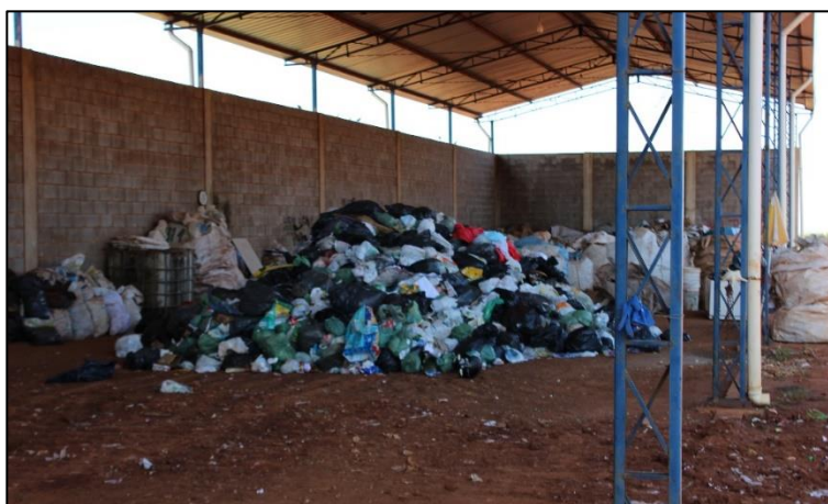
Figura 76 – Galpão para reciclagem – 2014
