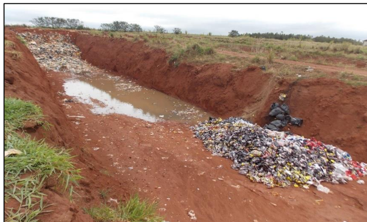
Figura 69 – Disposição irregular em valas não impermeabilizadas – 2013
