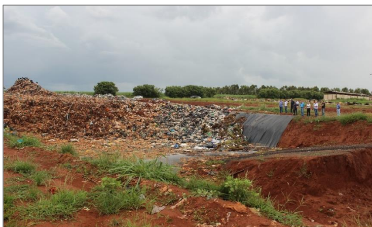
Figura 86 – Disposição irregular de resíduos – 2017
