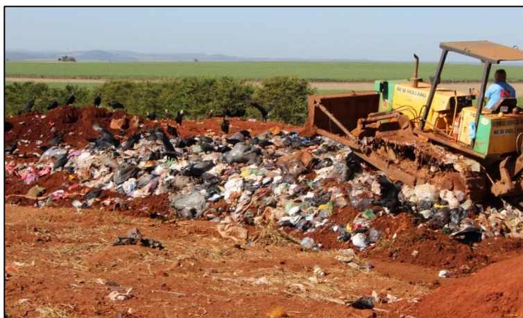
Figura 74 – Compactação dos resíduos sólidos e presença de aves – 2014
