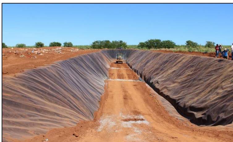
Figura 77 – Construção de nova vala para recebimento de resíduos – 2014
