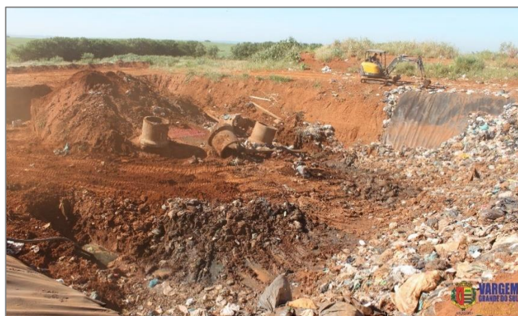
Figura 89 – Recuperação das valas irregulares – 2017
