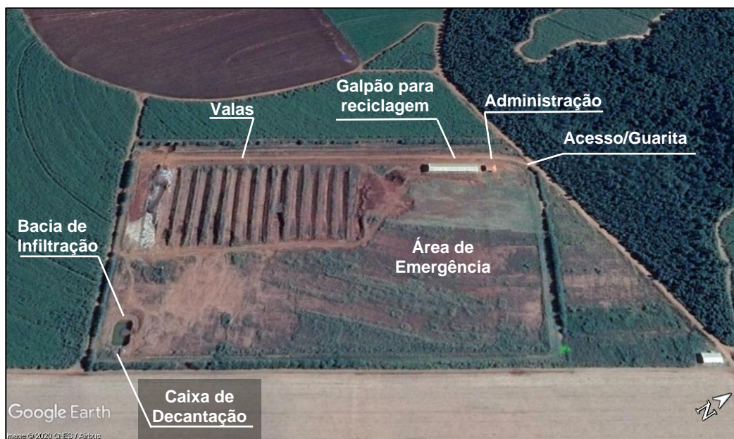
Figura 62 – Principais estruturas do aterro sanitário
