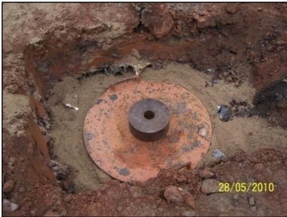
Figura 4.7 - Assentamento da placa de aço
