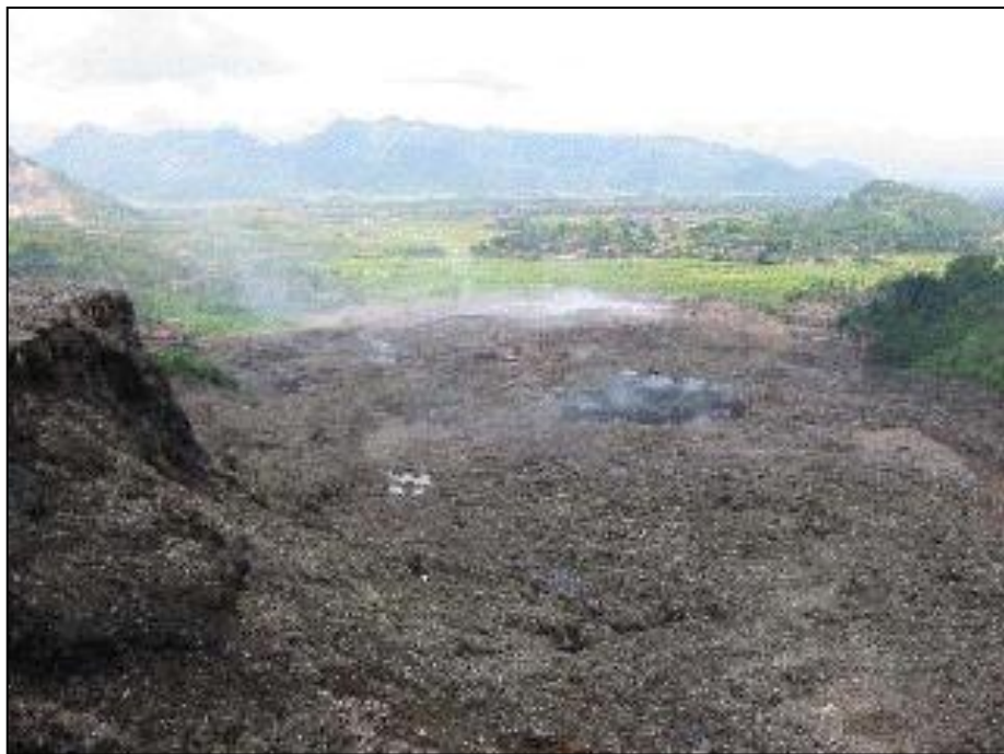
Figura 3.3: Aterro de Leuwigajah após ruptura (KAVAZANJIAN, 2010)
