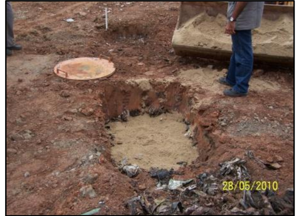
Figura 4.6 - Regularização da superfície de ensaios com areia
