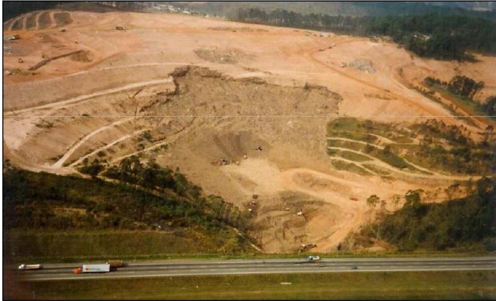
Figura 3.7 – Ruptura do aterro sanitário Bandeirantes (Brasil) em 1991 (BENVENUTO, 2008)
