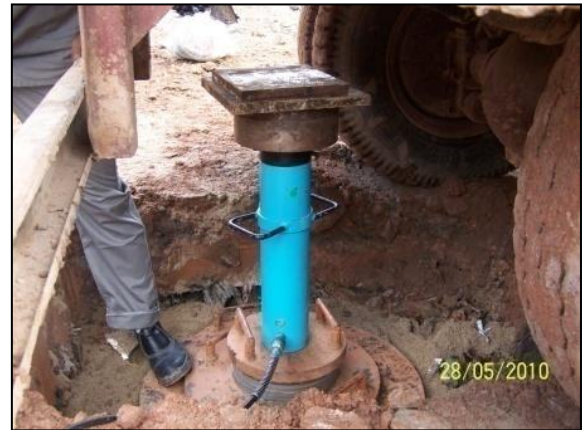
Figura 4.8 – Posicionamento do macaco hidráulico
