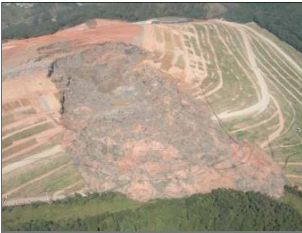
Figura 3.8 – Ruptura do aterro sanitário Sítio São João (Brasil) em 2007 (BENVENUTO, 2008)
