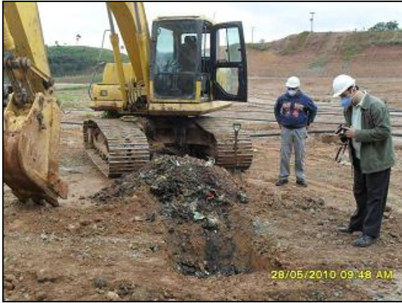
Figura 4.5 - Abertura da cava para realização do ensaio de placa
