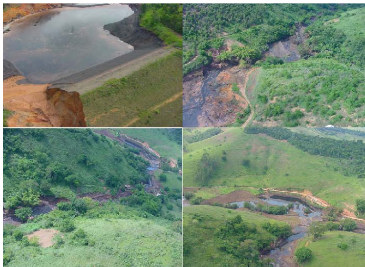
Fotografia 14: Acidente de Cataguases, rompimento do dique com vazamento de produto químico.
