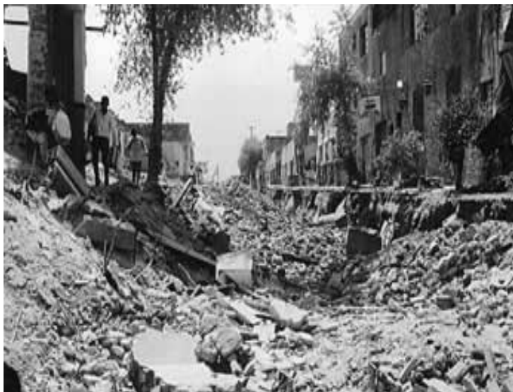
Fotografia 6: Aspecto da Rua em Guadalajara (México), após explosões da tubulação subterrânea e rede de esgotos, em 1992.
