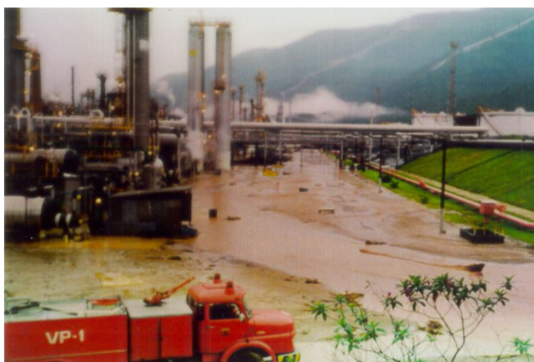
Fotografia 12: Instalações da Refinaria de Presidente Bernardes (RPBC/PETROBRAS), atingida por uma corrida de lama, em 1994.
