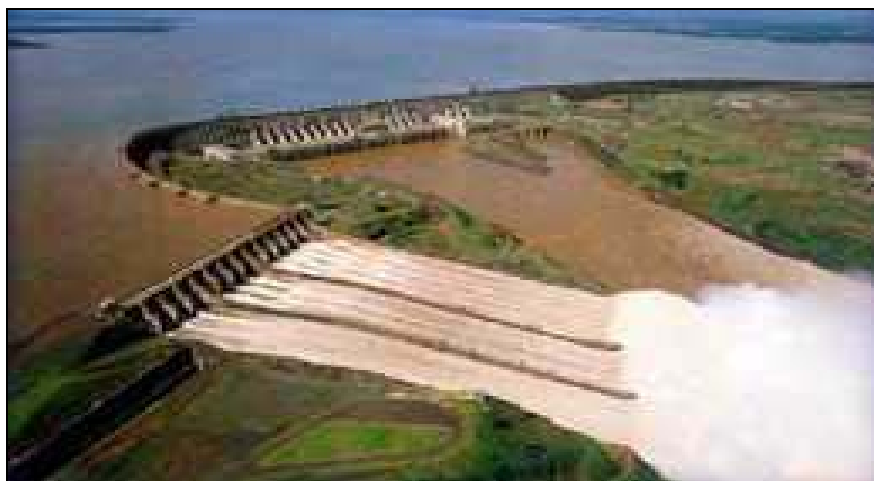
Figura C.03- Vista aérea da usina (ITAIPU BINACIONAL, 2002).
