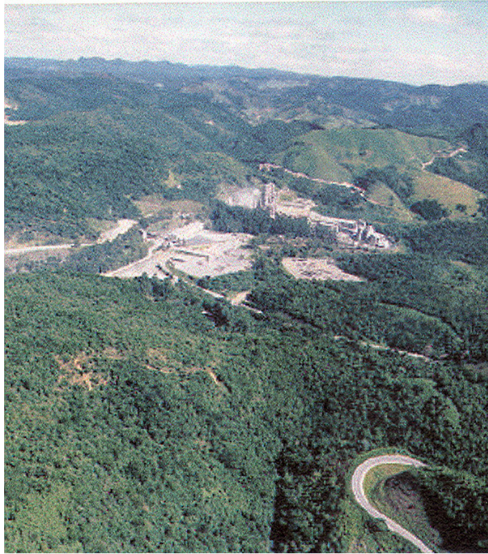
Figura 6.2 – Vista geral do parque industrial da CCRG Fonte: BARBOSA e SANTOS(1999), modificada pelo autor
