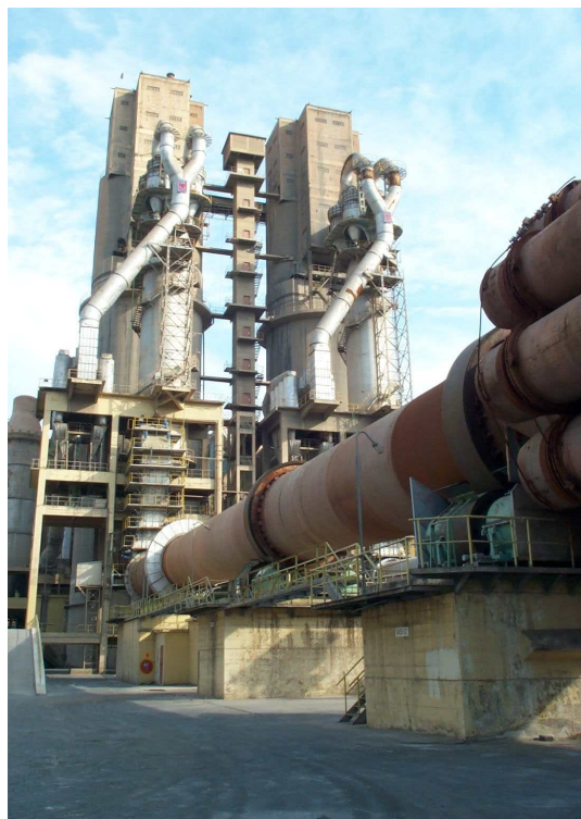
Figura 6.4 – Vista lateral do forno nº 1 da CCRG, observando-se ao fundo os pré-aquecedores, tipo intercambiadores, integrantes das duas linhas produtivas e atrás os silos de concreto para armazenamento de farinha Fonte: Foto cedida pela Companhia de Cimento Ribeirão Grande - CCRG
