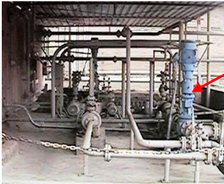
Figura 6.8 – Vista do parque de bombas com indicação de um moinho de linha Fonte: Barbosa e Santos (1999)
