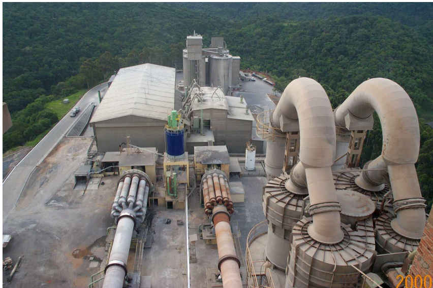
Figura 6.3 – Vista parcial das instalações industriais da CCRG, observando-se o forno nº 2 à esquerda e o forno nº 1 à direita. No primeiro plano, à direita, observa-se parte do pré-aquecedor do forno nº 1 e ao fundo, à esquerda, o galpão de clínquer tendo ao lado as instalações de moagem e armazenamento de cimento
