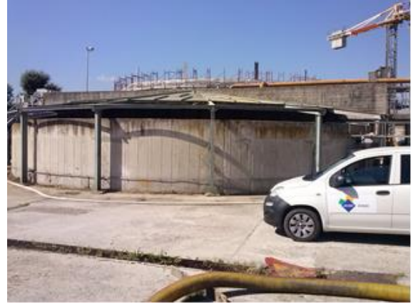
Imagem 13: Reservatório de lodo na etapa pré-tratamento, ETE Roma Nord, setembro de 2014.
