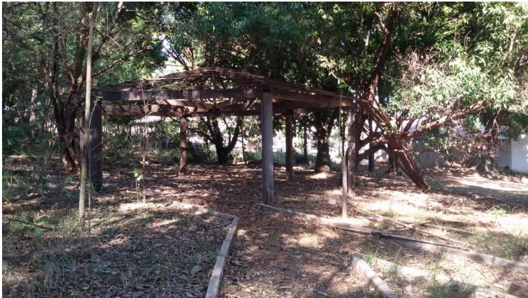
Figura 5.10. Vista do quiosque e das trilhas de acesso interno ao bosque, com as obras paralisadas em 2014.
