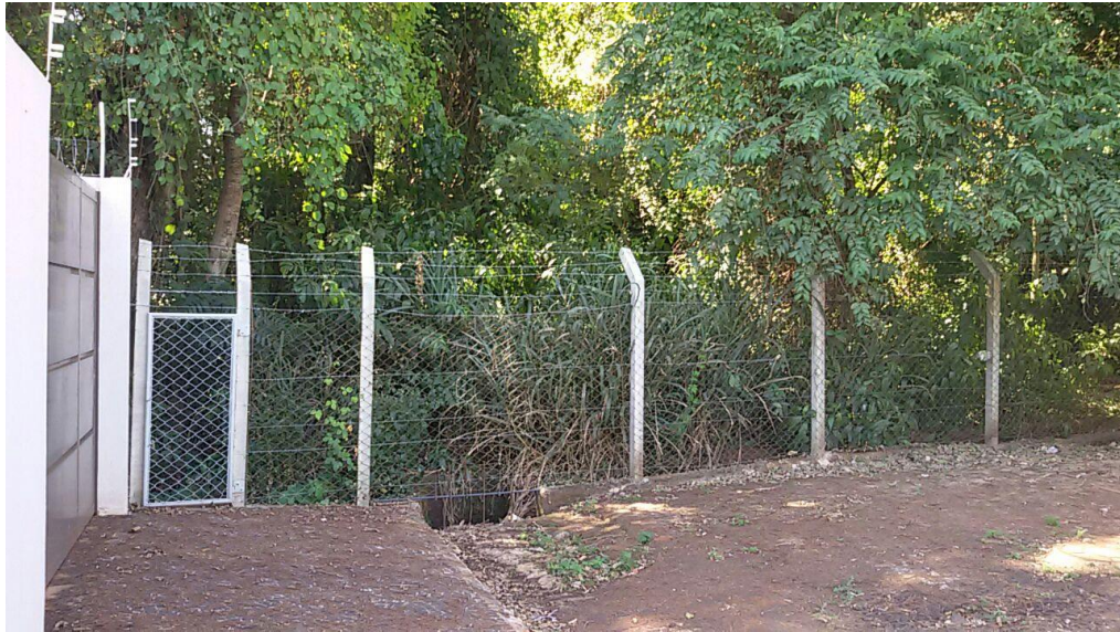
Figura 5.8. Ponto de lançamento da galeria de águas pluviais.
