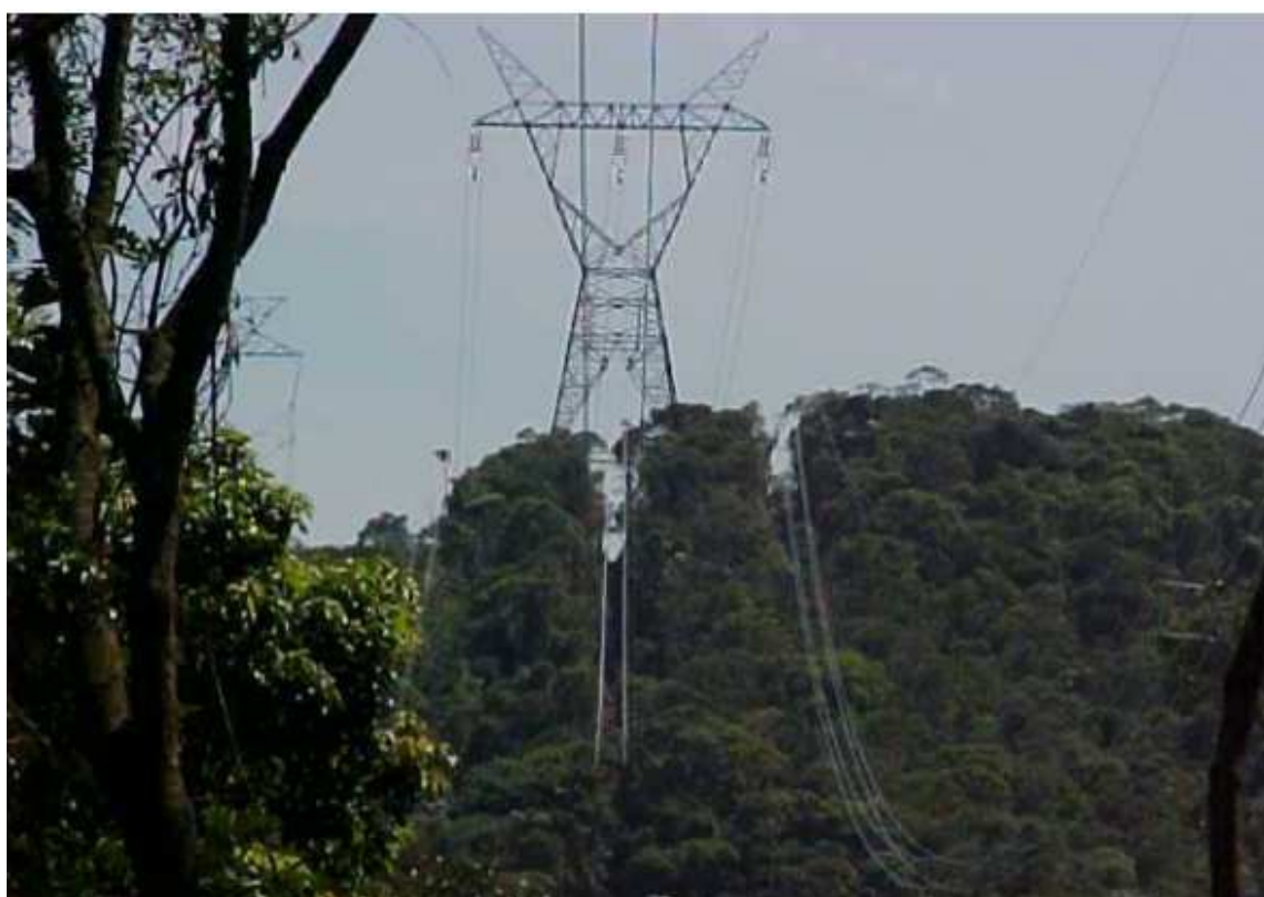
Figura 8 – Supressão no vão da faixa necessária para o lançamento dos cabos (“picadas”). Fonte: Arquivo da CETESB.
