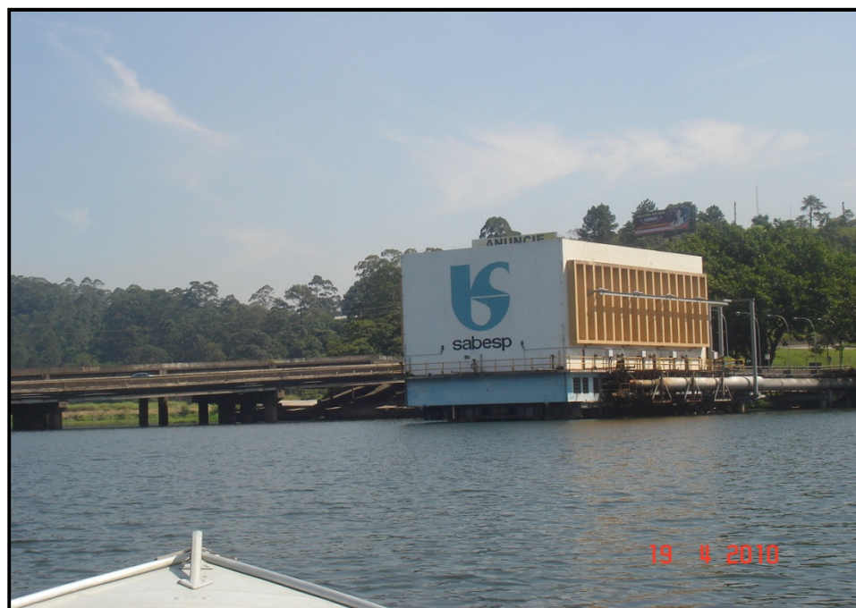
FIGURA 3.8 – Localização do ponto 4, perto da captação de água da SABESP (ao fundo, a Rodovia Anchieta)
