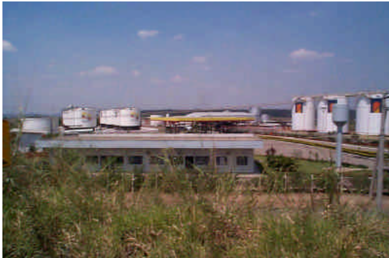
Foto 3- (Área da Cascata), avenida destinada à instalação de bases, nos fundos do posto da polícia militar rodoviária (SP-332), onde estão instaladas 04 bases de distribuição de combustíveis, sendo que há mais 02 em construção.
