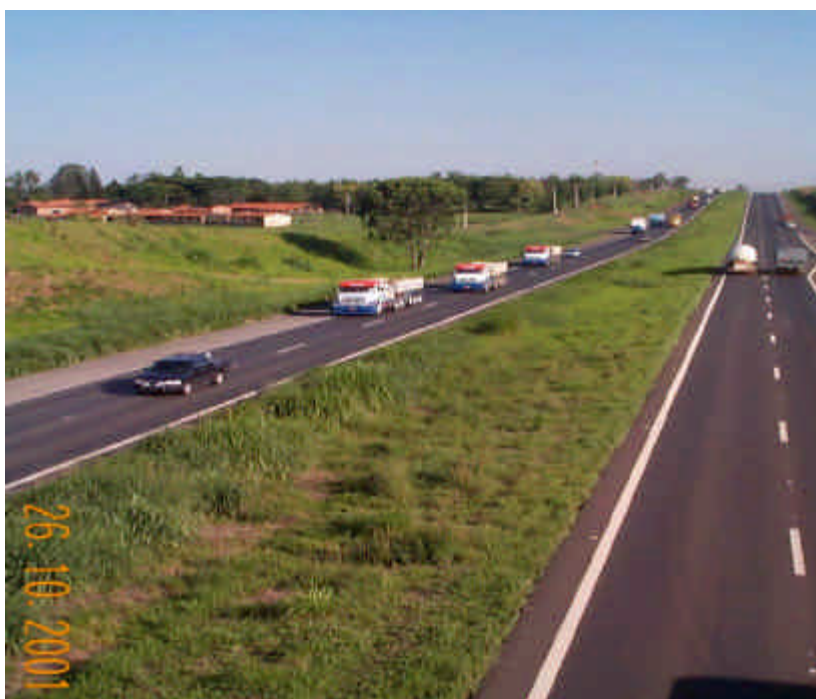
Foto 6- Vista da rodovia SP-332, na ponte da Du Pont, acesso para Paulínia, onde no instante da foto observa-se 09 caminhões trafegando, segundo levantamento do DER, neste trecho circulam 9.000 caminhões/dia.
