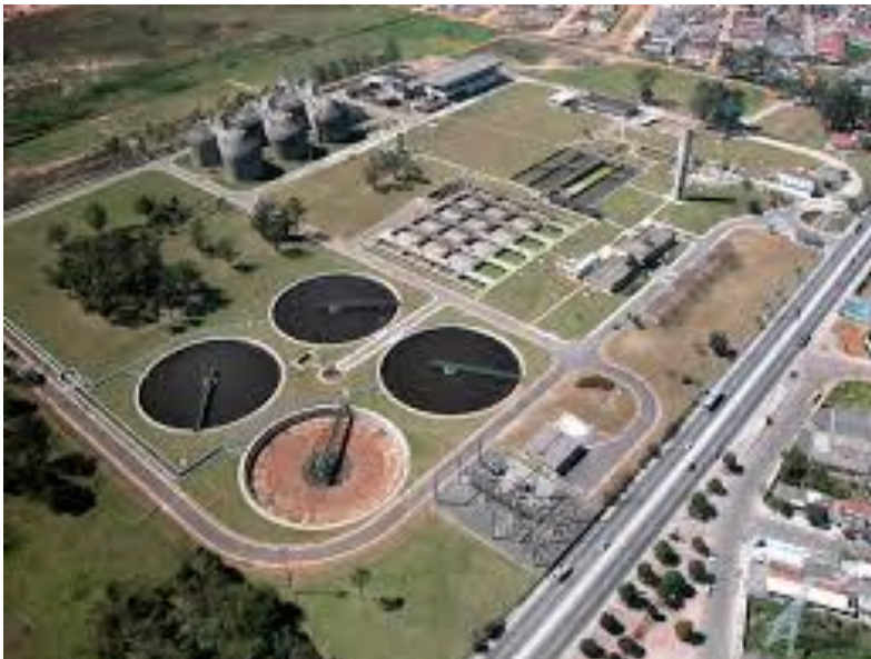
Figura 9 – Estação de tratamento de esgoto (ETE)
