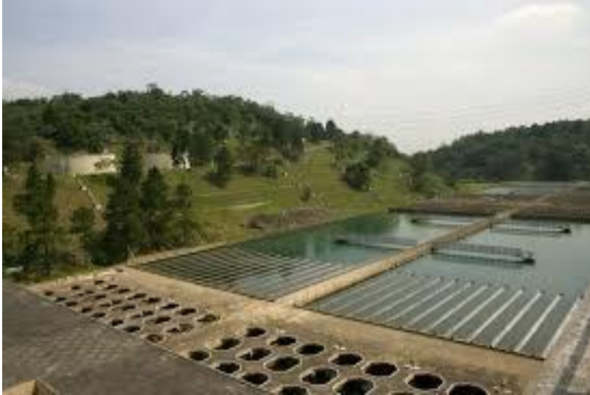
Figura 10 - Estação de tratamento de água (ETA)
