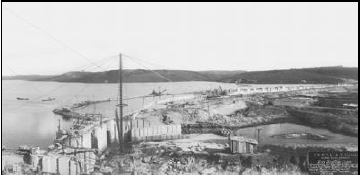
Figura 6: Foto (1928) Construção da Barragem Pedreira (CAPOBIANCO & WHATELY 2002)
