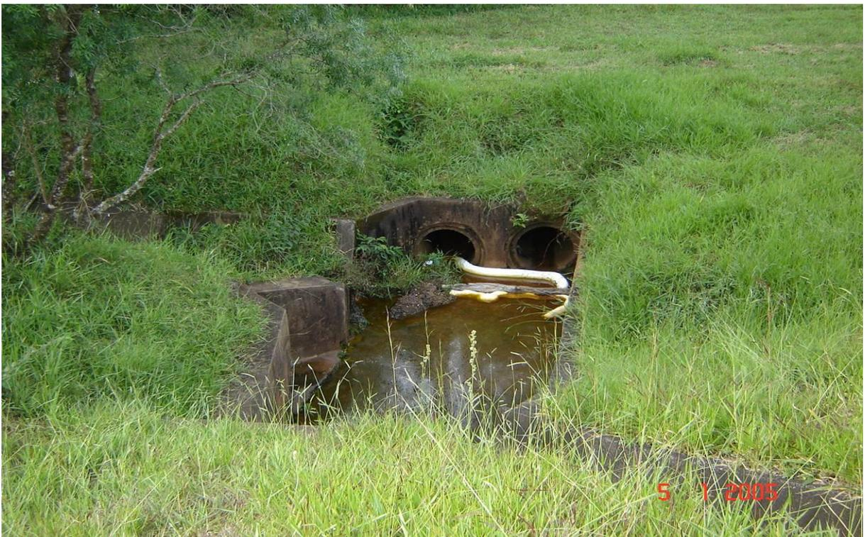
Figura 11 - Foto de Barreira para contenção de produtos flutuantes em galeria de águas pluviais.
