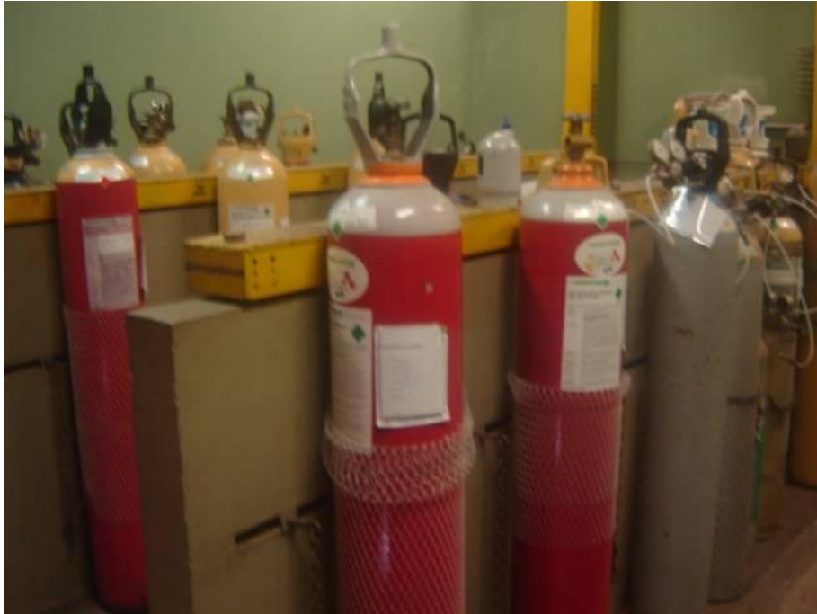
Figura 14: Foto da sala de armazenamento de gases
