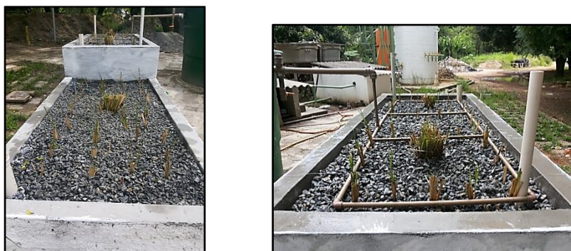
Figura 22. Câmaras de fluxo vertical e de fluxo horizontal após o 1º transplântio de mudas e touceiras
