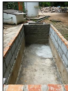
(b) Vista a jusante
