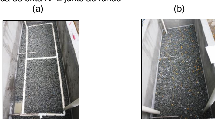
Figura 13. Sistema de coleta e drenagem de esgoto da câmara de fluxo vertical e camada de brita Nº 2 junto ao fundo
