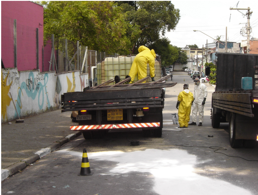
Foto 2 - Neutralização de ácido clorídrico com cal hidratada
