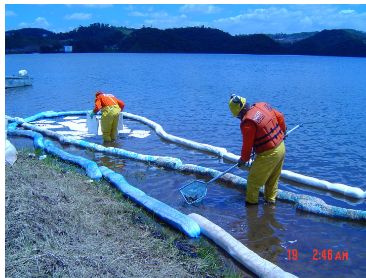
Foto 2 - contenção com barreira absorvente de líquido insolúvel e mais leve que a água
