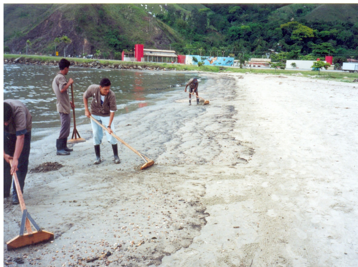
Foto 4 – Remoção manual de óleo em praia.
