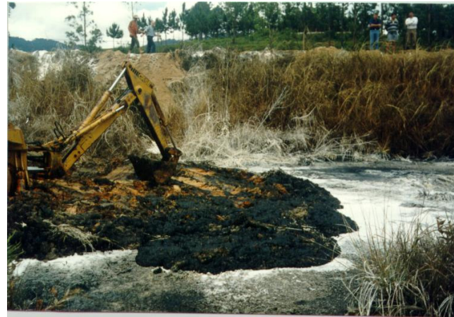
Foto 6 – Remoção de resíduos após a neutralização
