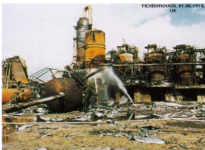
Fotografia 1: Destruição da planta industrial da Nypro Ltda, Flixborough, (Inglaterra), em 1974.
