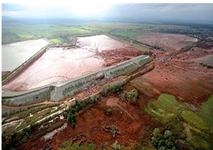
Fotografia 9: Rompimento do sistema de contenção do reservatório de resíduo, Da Usina Ajkai Timföldgyár, Hungria, em 2010.
