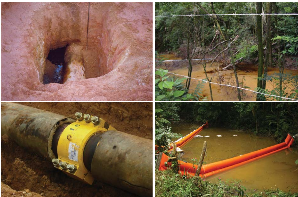
Figuras 4.17, 4.18, 4.19 e 4.20: Vazamento de óleo proveniente de duto.
