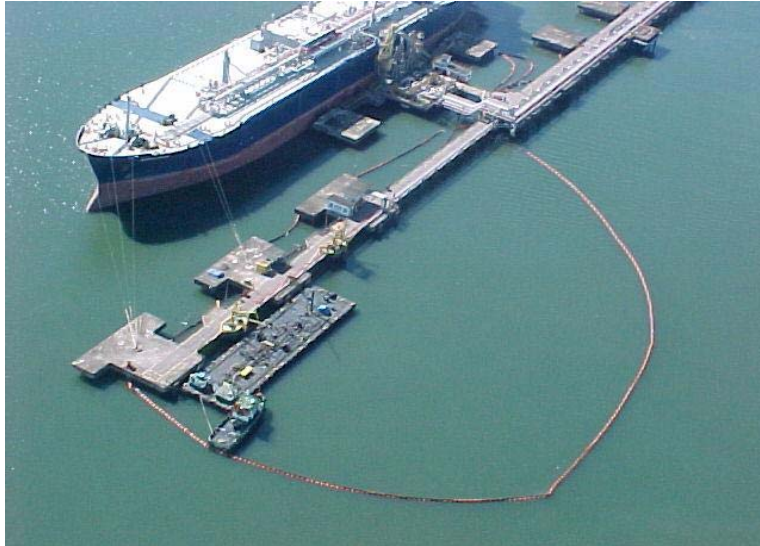
Terminal Aquaviário adotando barreiras de contenção como medida preventiva Foto: arquivo CETESB – Setor de Operações de Emergência
