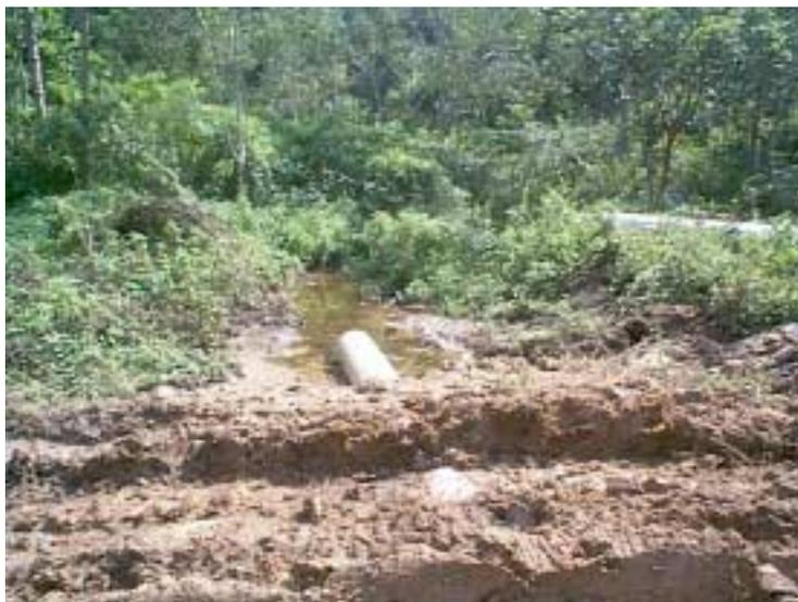
*Figura 92 - Córregos tubulados emergencialmente na faixa de dutos para minimizar os impactos da obra e o assoreamento nos mesmos.*
