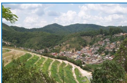
Vista lateral do aterro sanitário mostrando os taludes e bermas.
