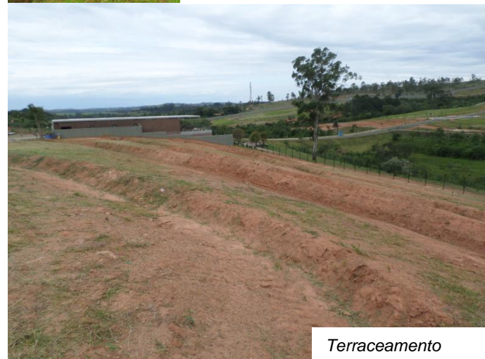
Proteção de taludes com gramíneas
