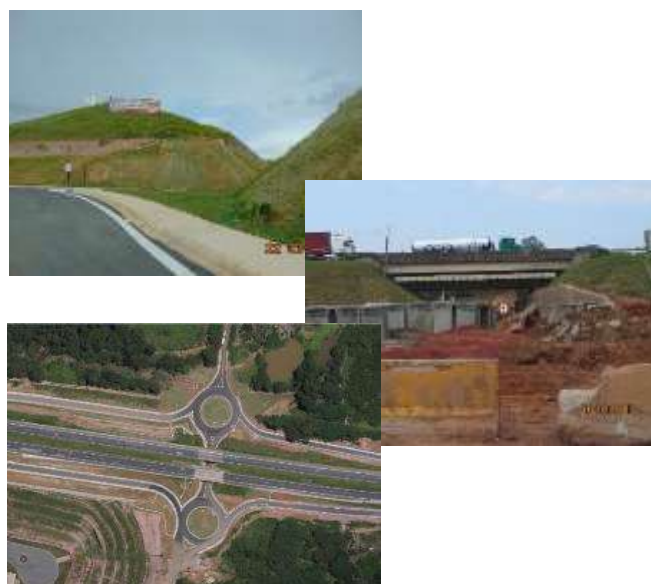
Obras viárias de acesso ao empreendimento
