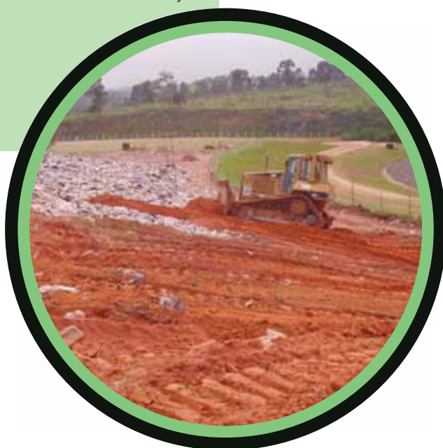
Lançamento, espalhamento e compactação dos solos de cobertura das camadas de resíduos do maciço
