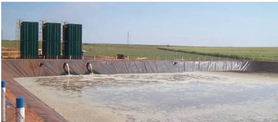
Tanque de resfriamento e armazenamento de vinhaça
