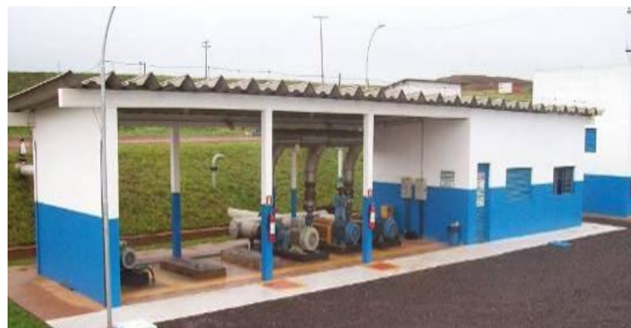
Estação de bombeamento da vinhaça para o campo
