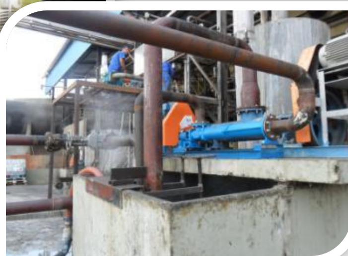
Caixa receptora dos pêlos e carnaça triturada
