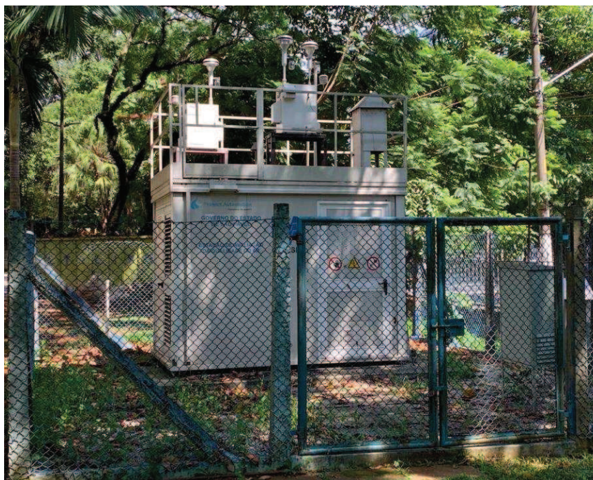
Figura 1 – Estação Cerqueira César
