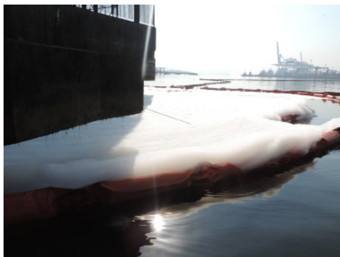
Foto 5.10 – Barreiras de contenção colocadas no entorno do píer do sistema de bombeamento da Ultracargo.
