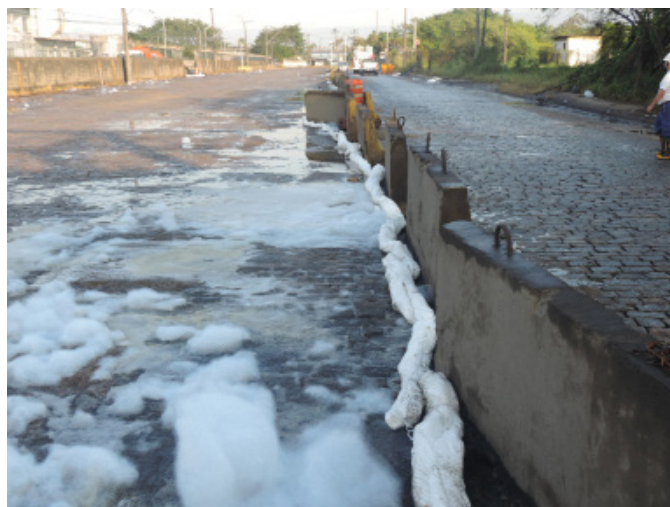
Foto5.9–Coloção de barreiras absorventes junto ao sistema de drenagens das vias públicas das proximidades da Ultracargo.
