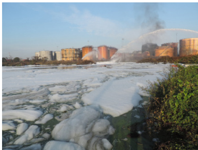
Foto5.11–Lagoa adjacente à Ultracargo com presença de macrófitas contaminadas com espuma de combate a incêndio.
