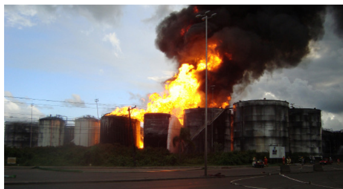
Foto 5.7 – Detalhe do incêndio em alguns dos tanques da Ultracargo.
