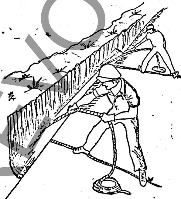
FIGURA 1 - Descida manual do tubo
