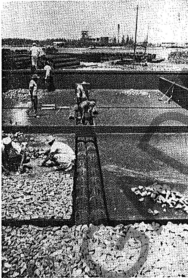
ILUSTRAÇÃO 9 - Arrumação dos materiais do meio filtrante em leito de secagem
