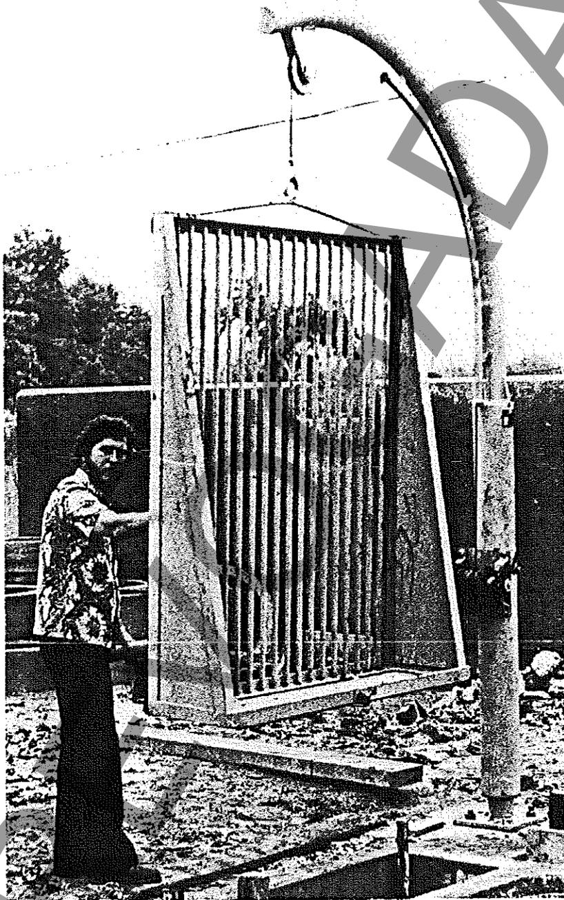
ILUSTRAÇÃO 2 - Grade de barras vertical, removível e de limpeza manual
